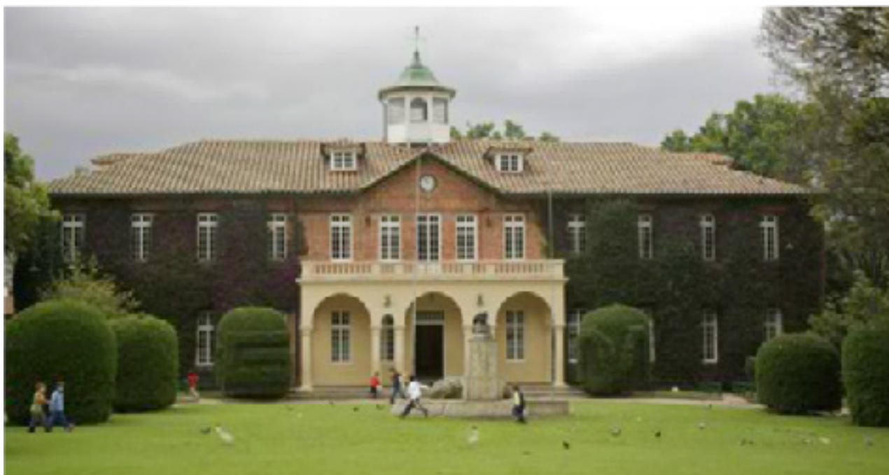
Fotografía Biblioteca Gimnasio Moderno de Bogotá, Carlos Lema, 2012. Extraída: http://es.investinbogota.org/arquitectura-de-bogota
