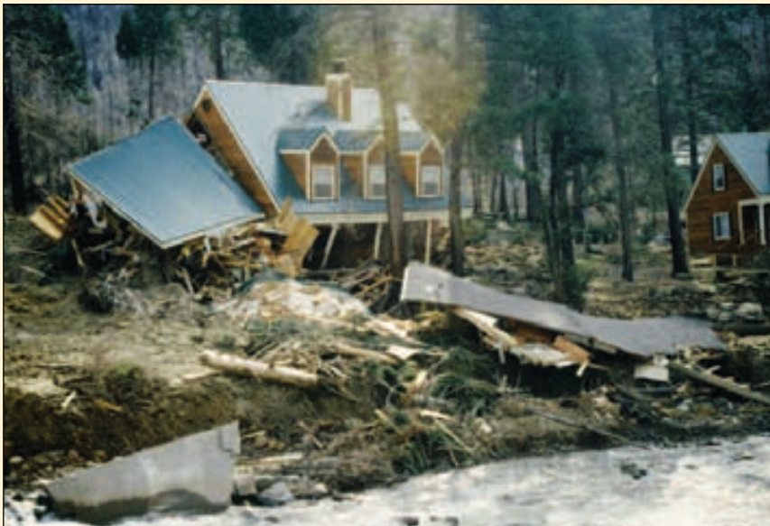
▲ Figura 15.B Casa destruida por un deslizamiento catastrófico súbito en 1997 a lo largo de la carretera U. S. 50, a unos 40 kilómetros al este de Placerville, California. (Foto de Mark Reid/U. S. Geological Survey.)
