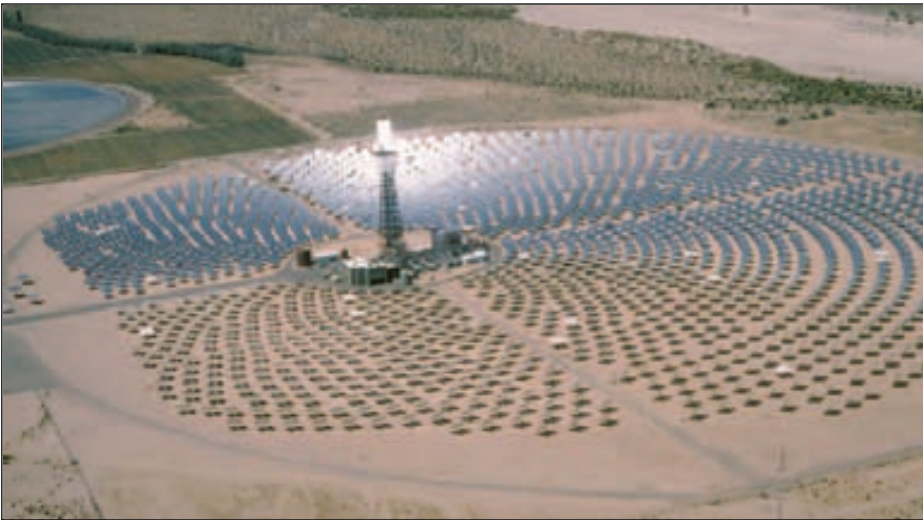
◀ Figura 21.12 Solar One, instalación solar utilizada para generar electricidad en el desierto de Mojave cerca de Barstow, California. (Foto de Thomas Braise/The Stock Market.)
