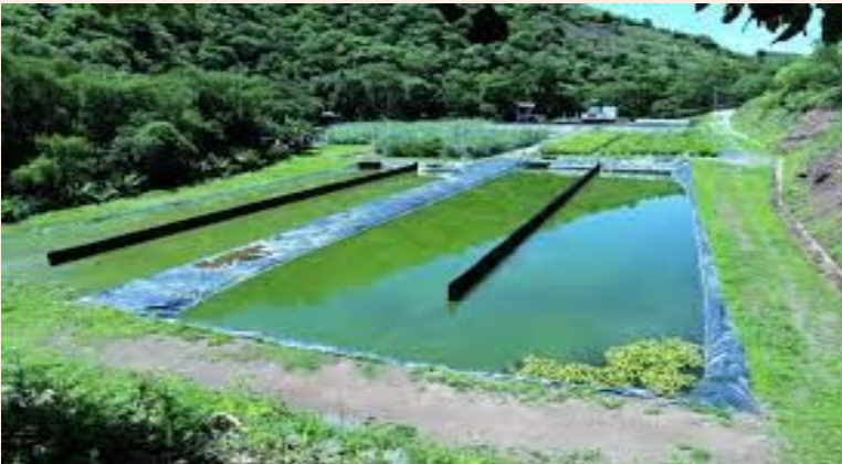
Figura 3: Lagunas aerobias. Tomado de https://es.slideshare.net/karliiYiss/lagunas-de-estabilizacion
