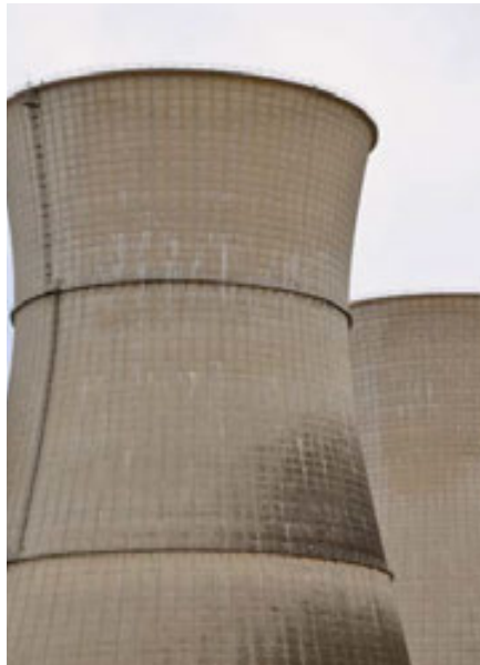
Los reactores nucleares tienen torres de enfriamiento en forma de hiperboloides.
